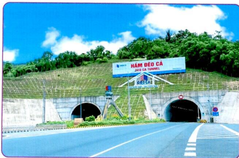
Hình 3.2. Hầm đường bộ Đèo Cả (Ảnh: Hoài Nhân)
