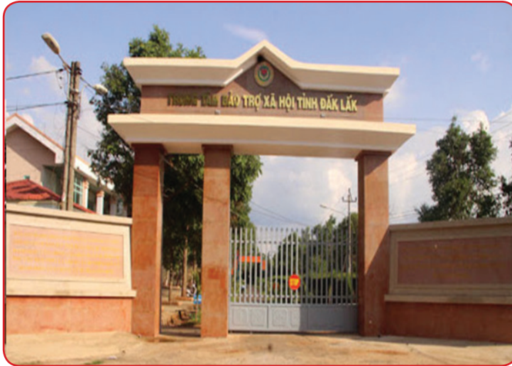
Hình 8.1. Trung tâm bảo trợ xã hội tỉnh Đắk Lắk Thôn 10, xã Hoà Thắng, thành phố Buon Ma Thuột, tỉnh Đắk Lắk.
